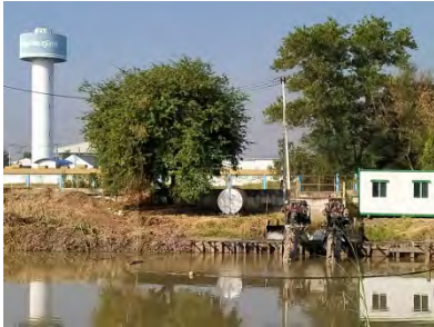
เครื่องสูบน้ำ ขนาด 24 นิ้ว จำนวน 2 เครื่อง
